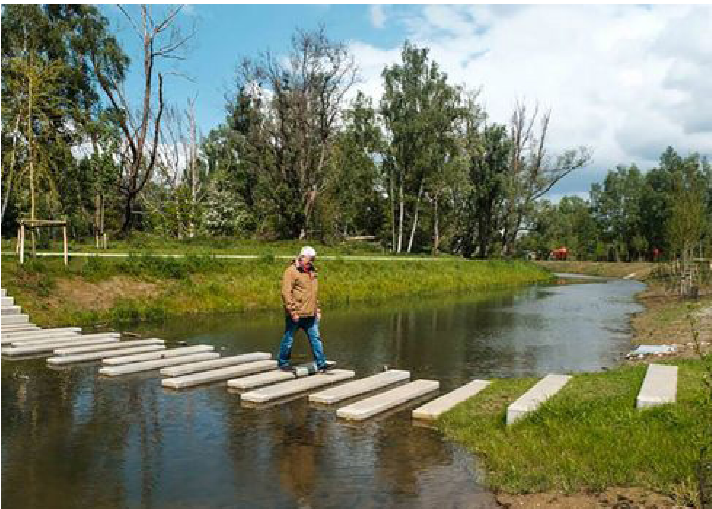
regenwateropvang met dubbele functie
